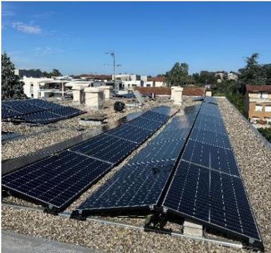
Ce lundi 7 octobre, les 91 panneaux photovoltaïques installés fin septembre sur le toit de **l'agence Caisse d'Épargne de Francheville (69)** sont mis en service. Des travaux qui offrent une capacité de 36KWc et une production potentielle qui permettra 40% d'autoconsommation.
